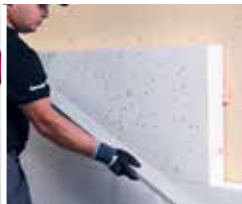
Přiteplení stávajících ETICS izolačními deskami "zateplení na zateplení"
