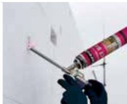
Dodatečné lepení uvolněných izolačních desek.
