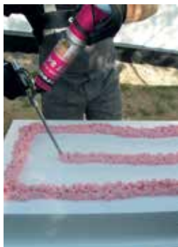
Lepení izolačních desek EPS
