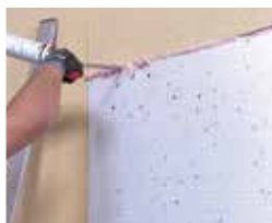
Vyplnění mezery mezi izolačními deskami.
