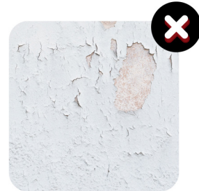
Loupající se stěna
