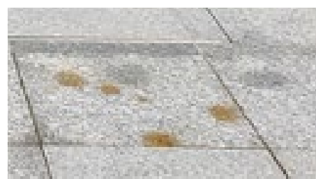
Rezané skvrny způsobené cizími tělesy (obrázek 2)
