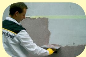
Dekorativní omítka se nanáší nerezovým hladítkem v minimální síle vrstvy tak, aby byl podklad zrnky stejnoměrně dokonale zakrytý.
