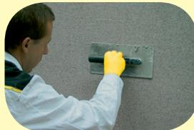
Vyhlašení se provádí opět nerezovým hladítkem ihned po nařesení, ještě před zaváděním dekorativní omítky. Nářadí je nutno průběžně umývat čistou vodou a následně očistit. Mokré hladítka zanechá na upravované ploše po zaschnutí viditelné stopy.
