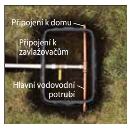
Vodoměr umístěný venku
