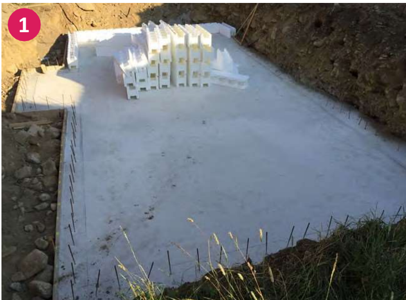
Kompletně vytvrzená základní deska
