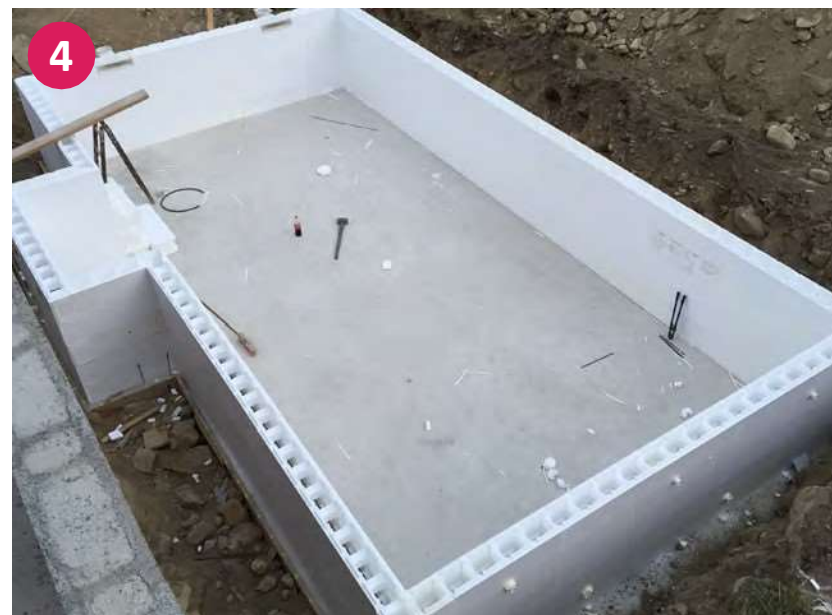
Hotový polystyrenový bazén - bez betonové výplně
