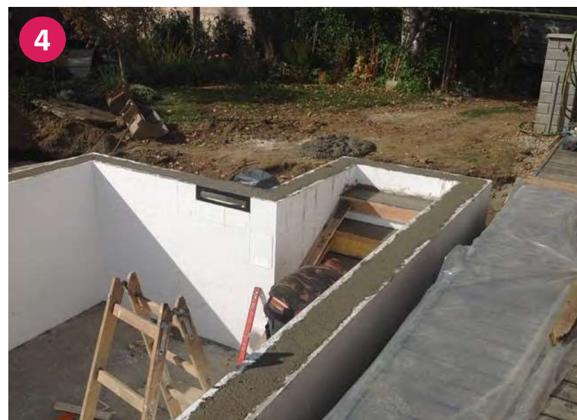
Zalítí polystyrenového bloku betonem
