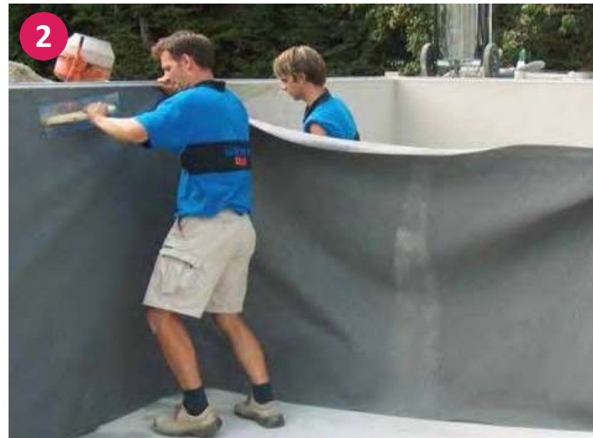
Bodové připevnění separační vrstvy z netkané geotextilie pomocí polystyrenového lepidla
