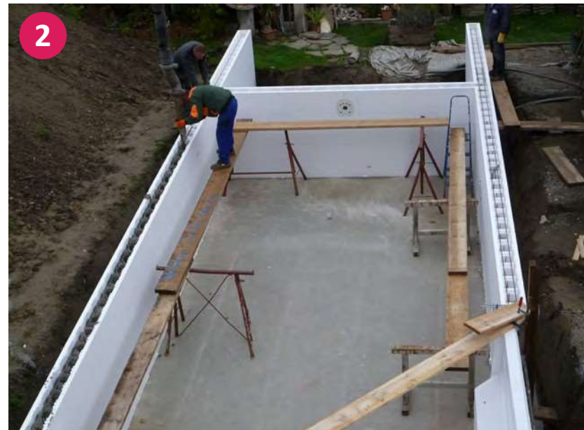
Zalítí polystyrenového bloku betonem
