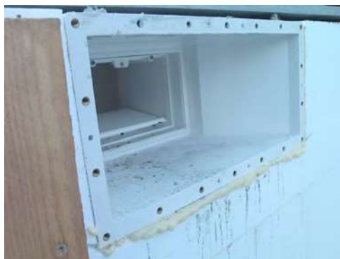
Kompletně zapěněný vstupní otvor skimmeru
