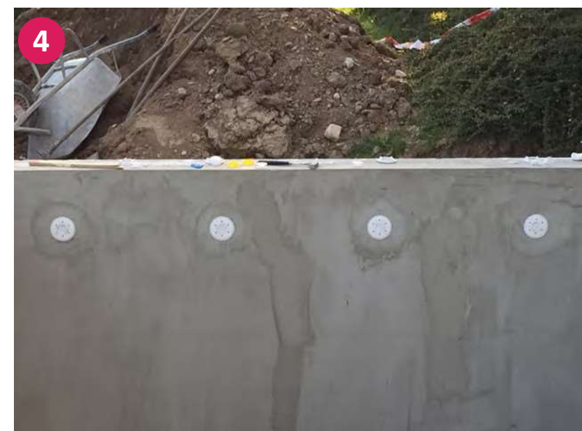
Důležité: před obsypáním bazénu natlakujte potrubí a ověřte těsnost!
