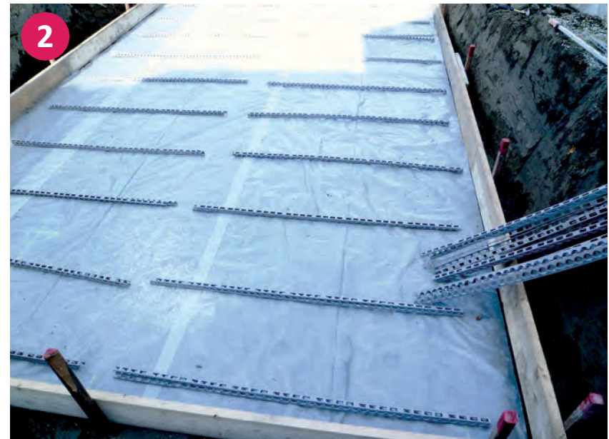
Bednění podlahové desky
