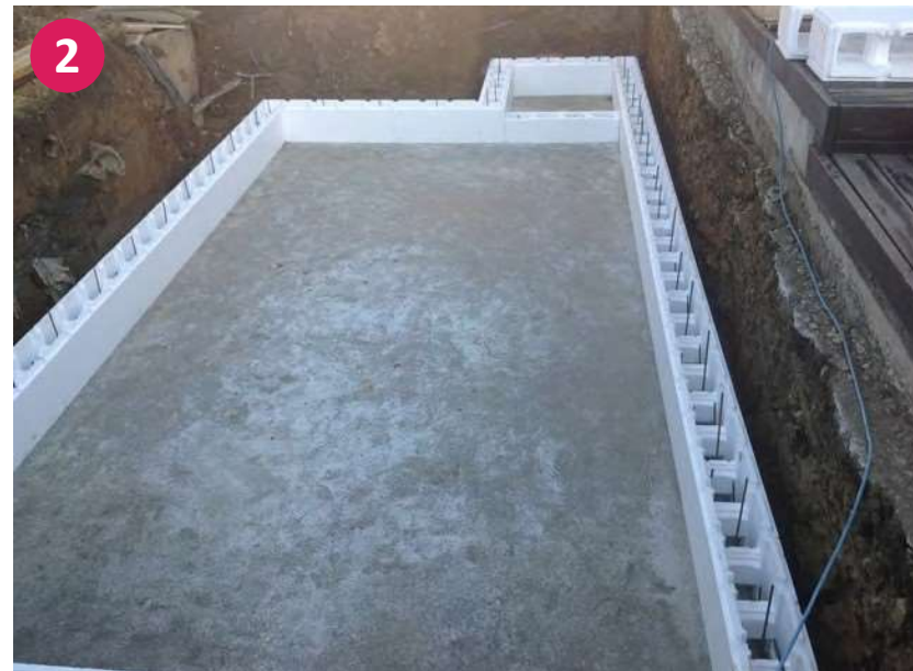
Usazení první řady polystyrenových bloků
