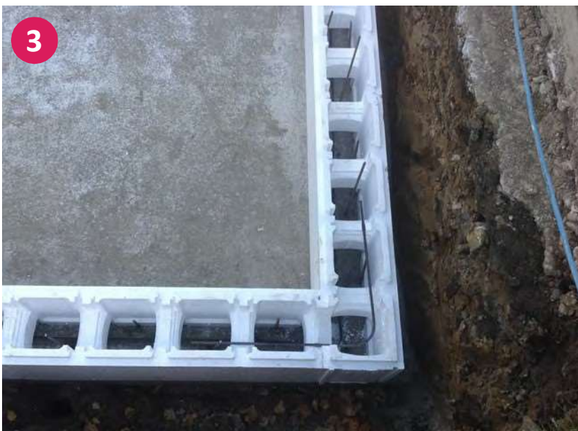
Detail rohového napojení včetně železné výztuže
