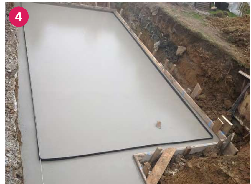
Podlahovou desku lze opatřit spárovací páskou pro dodatečné utěsnění
