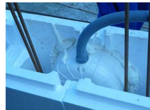
Uchycení tělesa reflektoru
