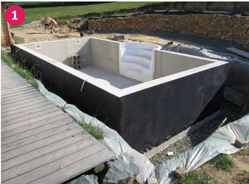
Vnitřní stěny doporučujeme navlhčit a vyrovnat
