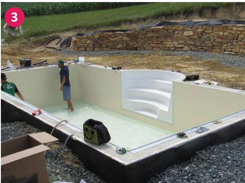
Zavěšení fólie a lemování na vestavěné díly
