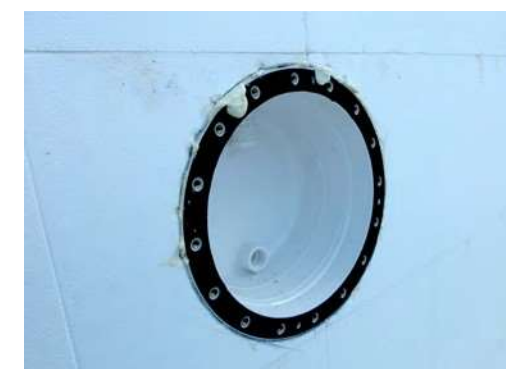
Kompletně zapěněné pouzdro reflektoru
