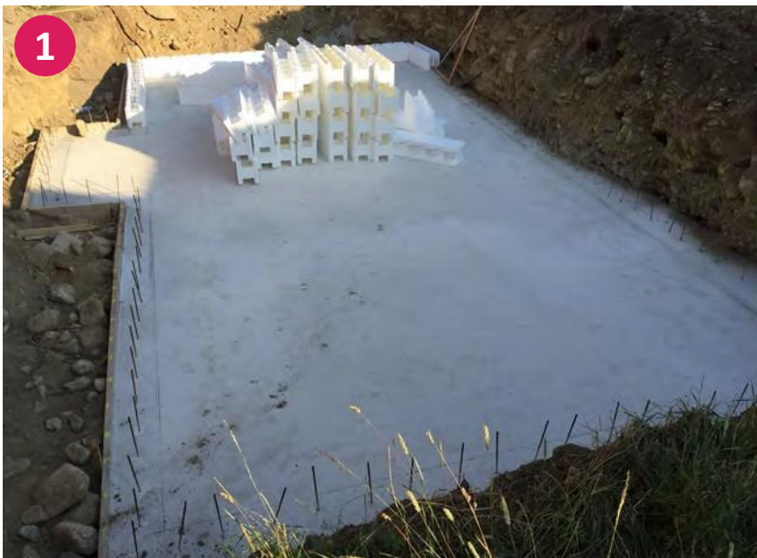
Kompletne vytvrdená základná doska
