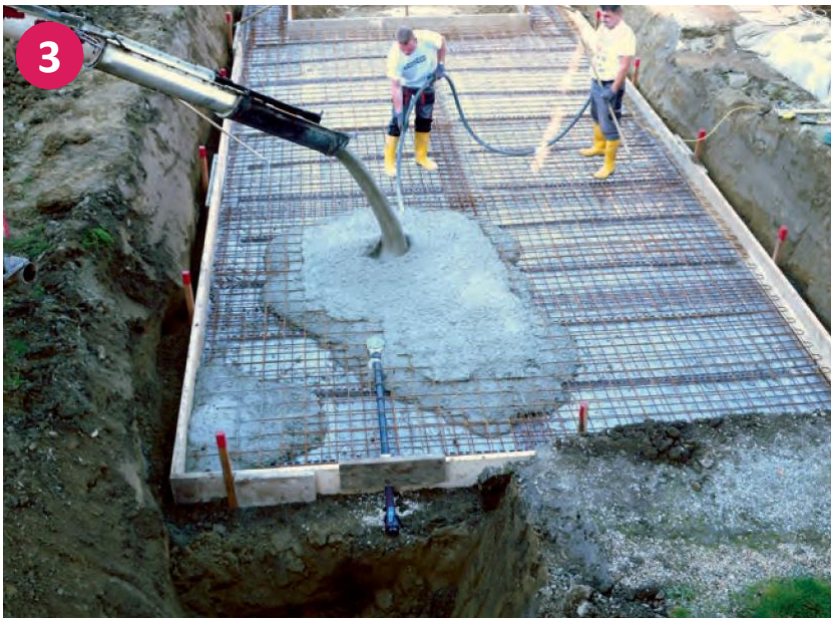
Uloženie železa a betónu do obedania podlahovej dosky
