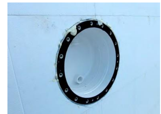
Kompletne zapenené puzdro reflektora
