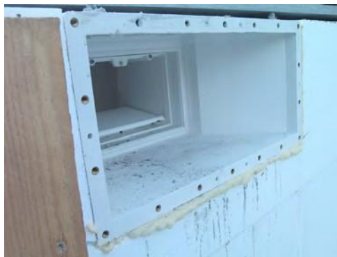
Kompletne zapenený vstupný otvor skimmera
