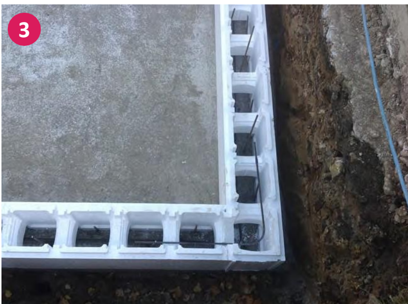
Detail rohového napojenia vrátane železnej výstuže
