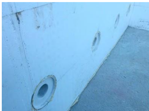
Kompletne zapenená stenová priechodka
