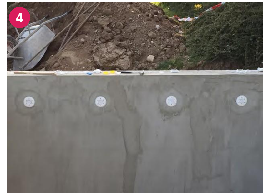
Dôležité: pred obsypáním bazéna natlakujte potrubie a overte tesnosť!
