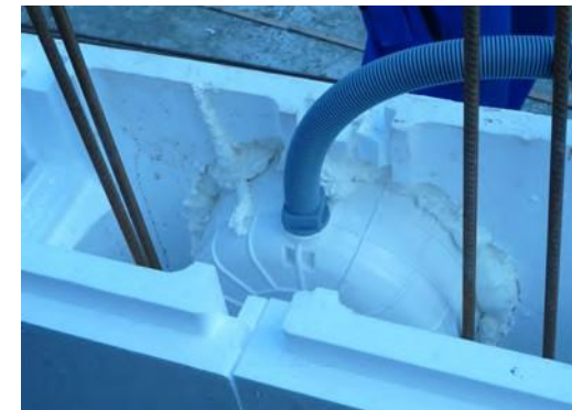
Uchytenie telesa reflektora
