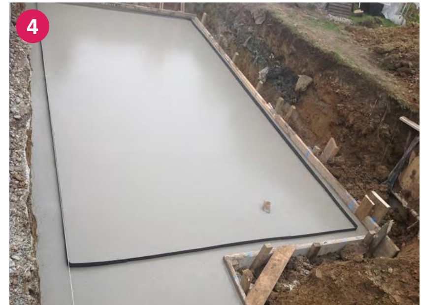
Podlahovú dosku je možné opatriť škárovacou páskou pre dodatočné utesnenie
