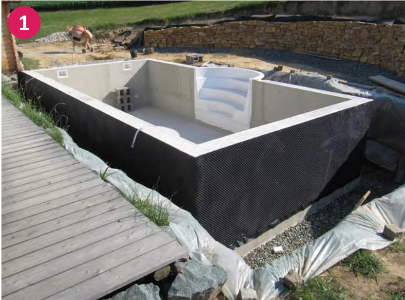
Vnútorné steny odporúčame navlhčiť a vyrovať
