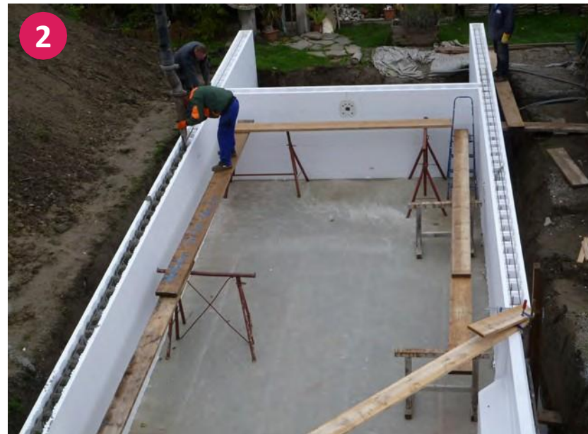
Zaliatie polystyrénového bloku betónom
