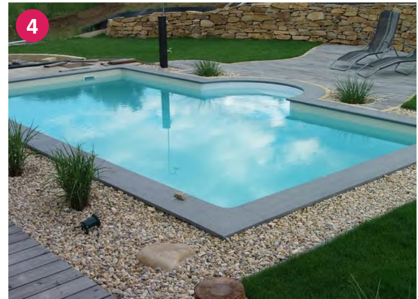
Hotový polystyrénový bazén s rímskymi schodmi
