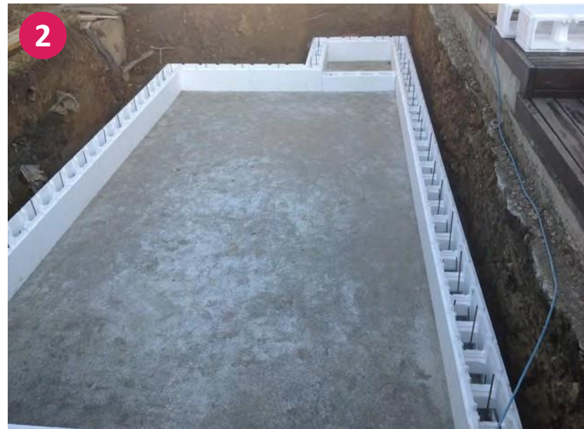
Usadenie prvého radu polystyrénových blokov
