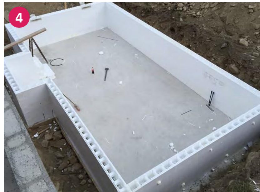
Hotový polystyrénový bazén - bez betónovej výplne
