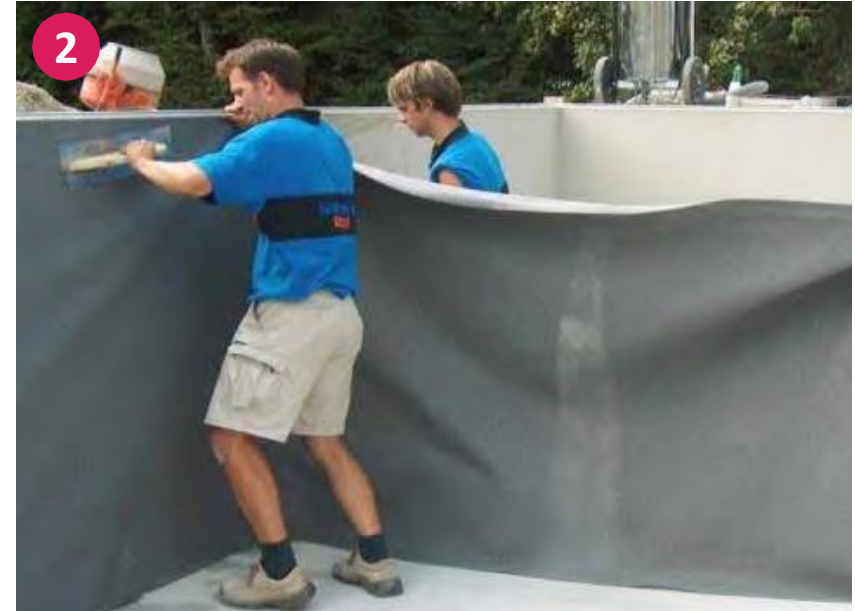
Bodové pripevnenie separačnej vrstvy z netkanej geotextílie pomocou polystyrénového lepidla
