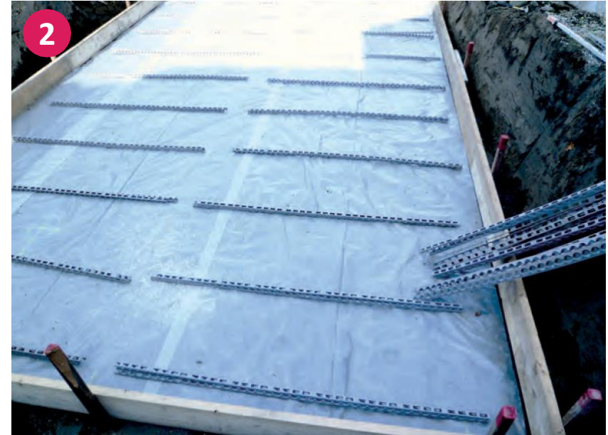
Debnenie podlahovej dosky
