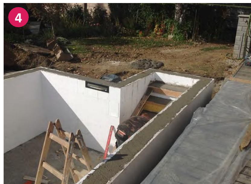
Zaliatie polystyrénového bloku betónom
