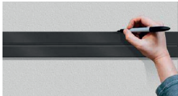
1. Určete polohu instalace, nakreslete čáru okolo horní části zásuvkové lišty.
