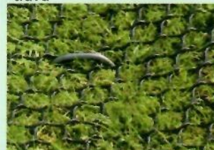
Rohož zajištěná hřeby
