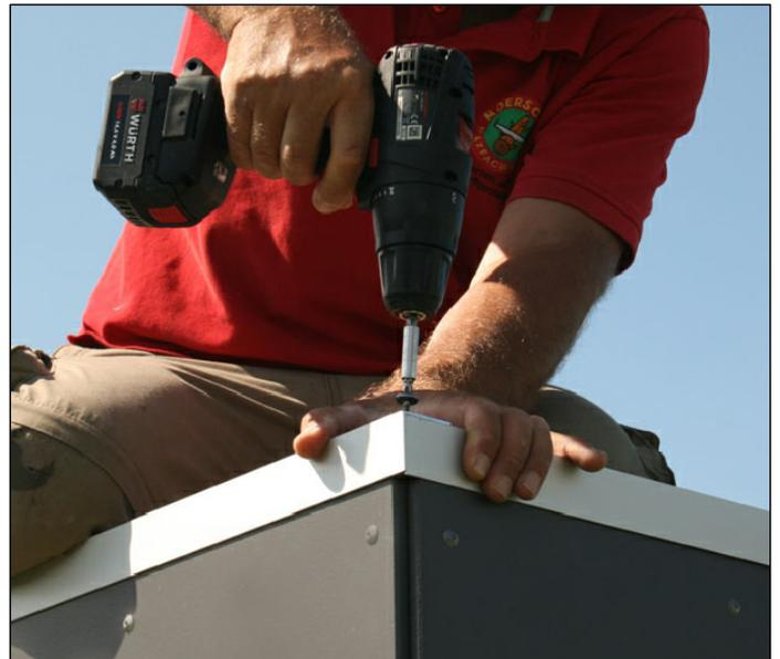
In den Ecken legen Sie die Schienen übereinander und verschrauben Sie diese mit nur einer Schraube zusammen.
