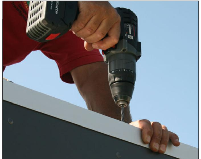
Verschrauben Sie die Aluminiumschienen ( A100-220) nach dem Vorbohren mit 6x C104-0030 an der Dachkante mit der Rähm. Lassen Sie die Längsstöße der Aluminiumschienen 2cm überlappen
