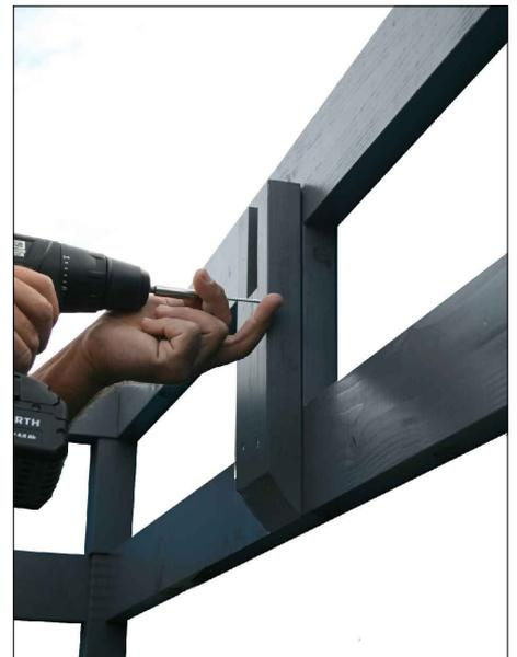
Verschrauben Sie die Pfettenschuhe nach dem Vorbohren mit jeweils 4x C105-0060 von innen an den Mittelpfosten.
