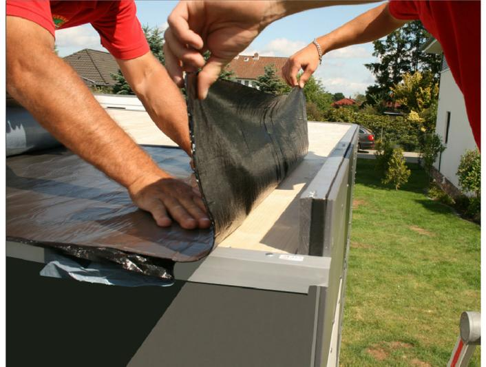
Verlegen Sie nun die selbstklebende Dachbahn. Das Verlegen der Bahn erfolgt quer zum Gefälle. Rollen Sie ca. 100cm der Folie ab und lassen Sie die Schutzfolie zum genauen Ausrichten der Bahn vorerst dran. Erst nach dem genauen Ausrichten ziehen Sie die Schutzfolie auf ca. 10cm ab und fixieren Sie die Bahn genau.
