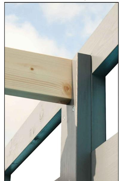
Legen Sie die Pfetten in die Aussparungen der Pfettenschuhe und verschrauben Sie die Pfetten nach dem Vorbohren mit je 1x C105-0080 von innen durch den Pfettenschuh.
