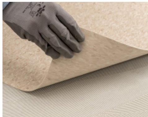
Instalace homogenního PVC s použitím Ultrabond Eco V4 Evolution ZERO
