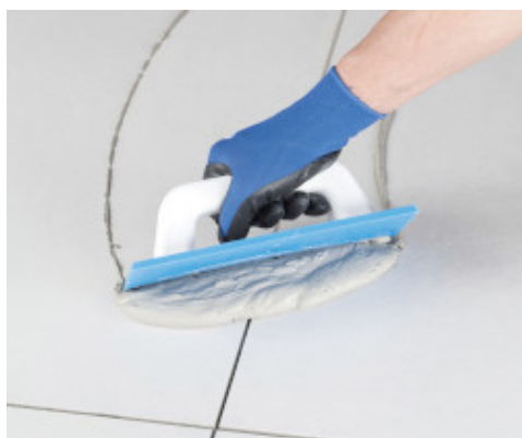
Nanášení Ultracoloru Plus gumovou stěrkou
