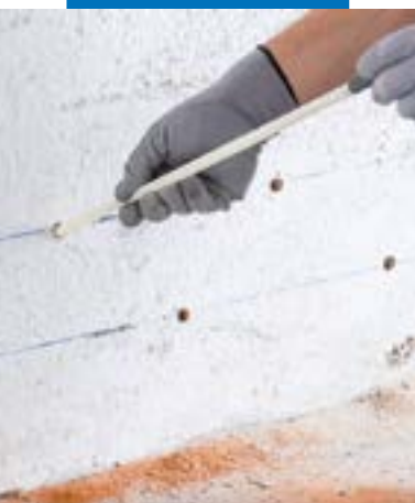
Vkládání injektorů do otvorů
