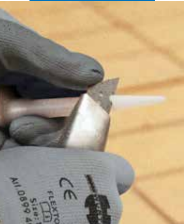
Odříznutí špičky trysky v závislosti na profilu spáry
