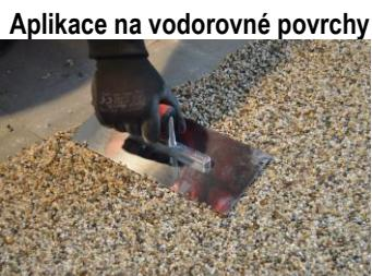
Smíchanou a připravenou směs epoxidového pojiva a kameniva aplikujeme na připravený povrch a stahujeme vodorovnou, deskou (u velkých ploch) nebo hladítkem (u malých ploch). Stažený povrch v požadované tloušťce **důkladně zatahujeme hladítkem** do hladka a kontrolujeme vizuálně.
