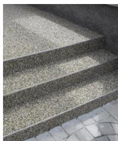
Hlavní postup při renovaci schodů je stejný jako u pokládky plochy. Podstupnice doporučujeme ošetřit penetračním EPOXY nátěrem nebo samotným pojivem pro kamenný / mramorový koberec. Pro renovací schodů se používá pouze otevřená struktura.
