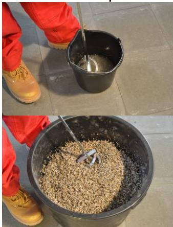
Tvrdidlo epoxidové pryskyřice (složku B) nalijeme do základu epoxidové pryskyřice (složku A). Směs složek A a B důkladně promícháme po dobu 3 minut pomocí míchadla s rychlosťí 300ot./min.
