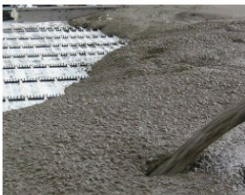
Lití betonu s obsahem Mapefibre NS12 proti plastickému smršťování
